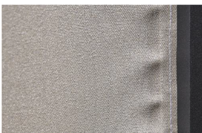
Afbeelding 23: Mogelijke toelaatbare plooiën bij zipsystemen bij de zijzoom (overgang met de ritssluiting)
