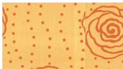
Afbeelding 4: Patroonverschuiving
